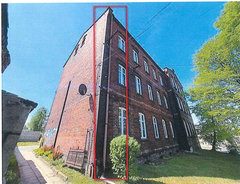
Fot. 5. Widok naroża budynku z zaznaczoną rurą spustową do wymiany.
