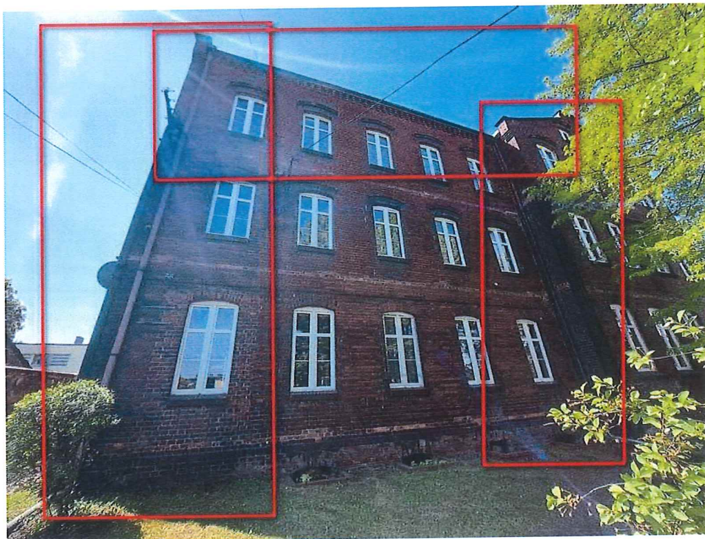
Fot. 3. Widok elewacji z zaznaczonymi rurami spustowymi oraz rynną do wymiany.
